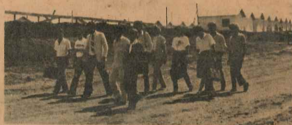
AS OBRAS DA COOPERATIVA SENDO VISITADAS PELOS SEUS DIRETORES E REPRESENTANTES DA ENCOL.
